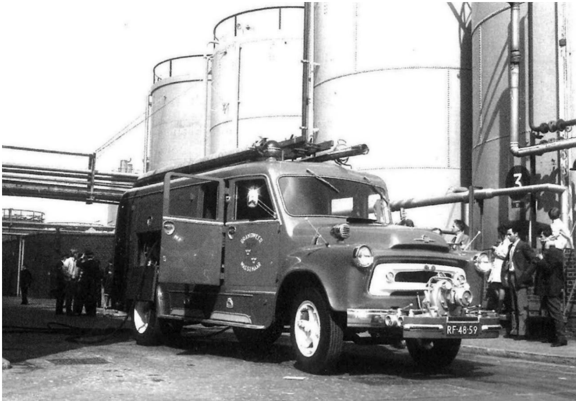
13.10 Mistspuit 2 uit 1957. Deze autospuit was voorzien van een lagedruk voorbouw pomp en was daardoor geschikt voor zowel hoge- als lagedruk blussing. De capaciteit van de lagedruk pomp bedroeg 2000 liter per minuut.
