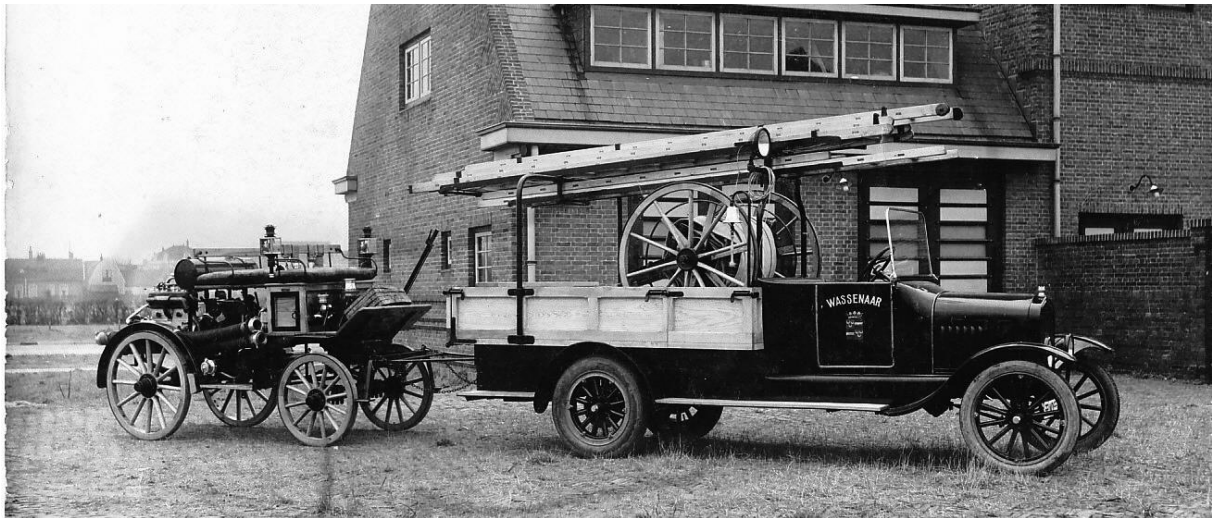
13.3 Met de aankoop van de Ford gereedschapswagen in 1925 behoorde paardentraction tot het verleden. De opbouw werd volgens een ontwerp van commandant Van der Mark uitgevoerd door de firma Geesink.
