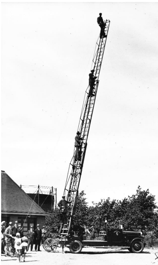
13.4 en 13.5 De Magirus autoladder welke in 1931 werd aangeschaft had een werkhogte van 16 meter. Op de rechterfoto is op de voorgrond de Chevrolet autospuit te zien. Dit voertuig met een opbouw van de firma Geesink had een pompcapaciteit van 2000 liter per minuut. Het voertuig was in 1941 gereed maar werd pas in 1943 afgeleverd. De foto is gemaakt bij een oefening in 1950.
